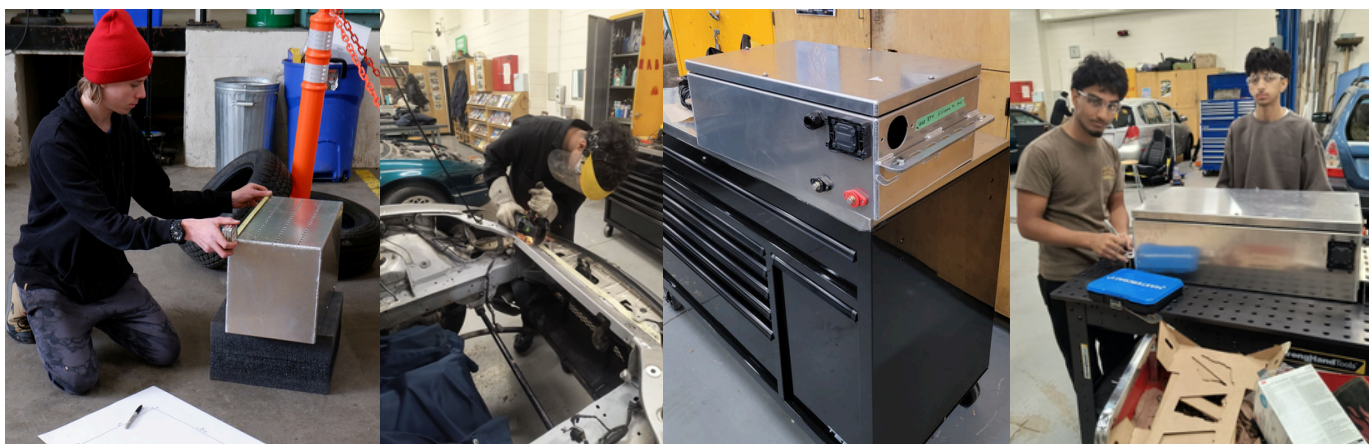
Des élèves des deux lycées prennent des mesures, soudent et travaillent sur les boîtiers de batterie en vue de leur installation.
