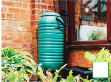
Mets un «✔» si le baril peut diriger l'eau à plus de deux mètres de la maison (p. ex., au moyen d'un tuyau de débordement qui permet l'écoulement de l'eau vers d'autres barils) ou s'il peut dériver le trop-plein d'eau vers la descente pluviale quand il est plein, comme le montre cette photo.
